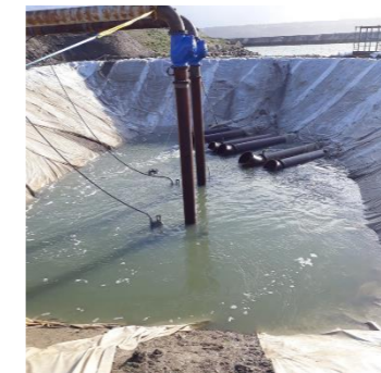
Figure 8 : Exemple de bassin de décantation des rejets
