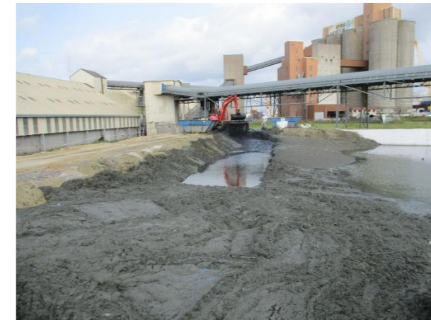
Figure 7 : Exemple de site de ressuyage de sédiments pollués dragués mécaniquement
