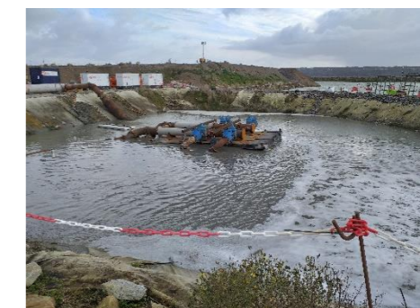
Figure 8 : Exemple de bassin de décantation des rejets
